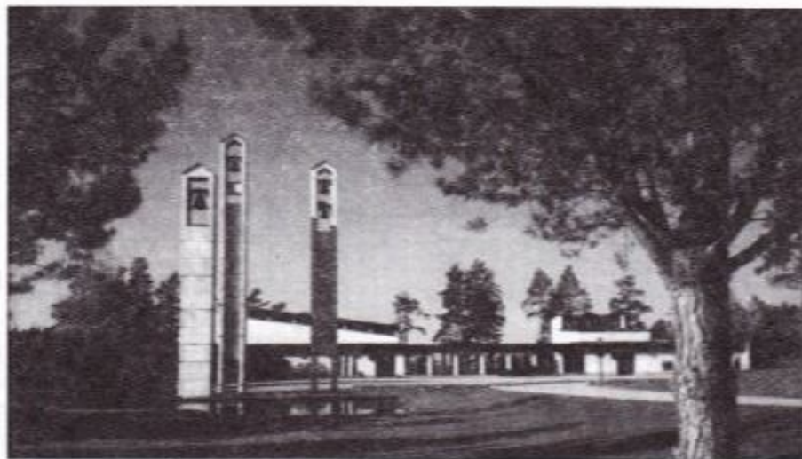
Krematorium z kaplicą w Szwecji.
